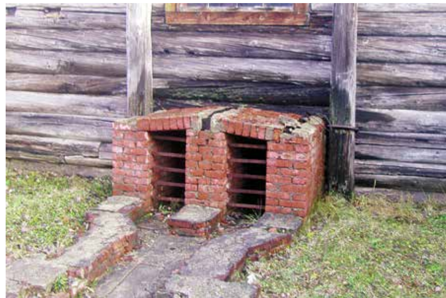
Дымоход из варницы в трубу.
