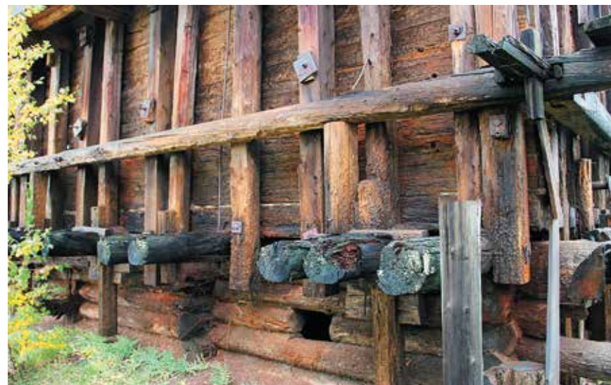
Горизонтальная рама, сжим из бревен соляного ларя и клин для подтяжки конструкции ларя.
