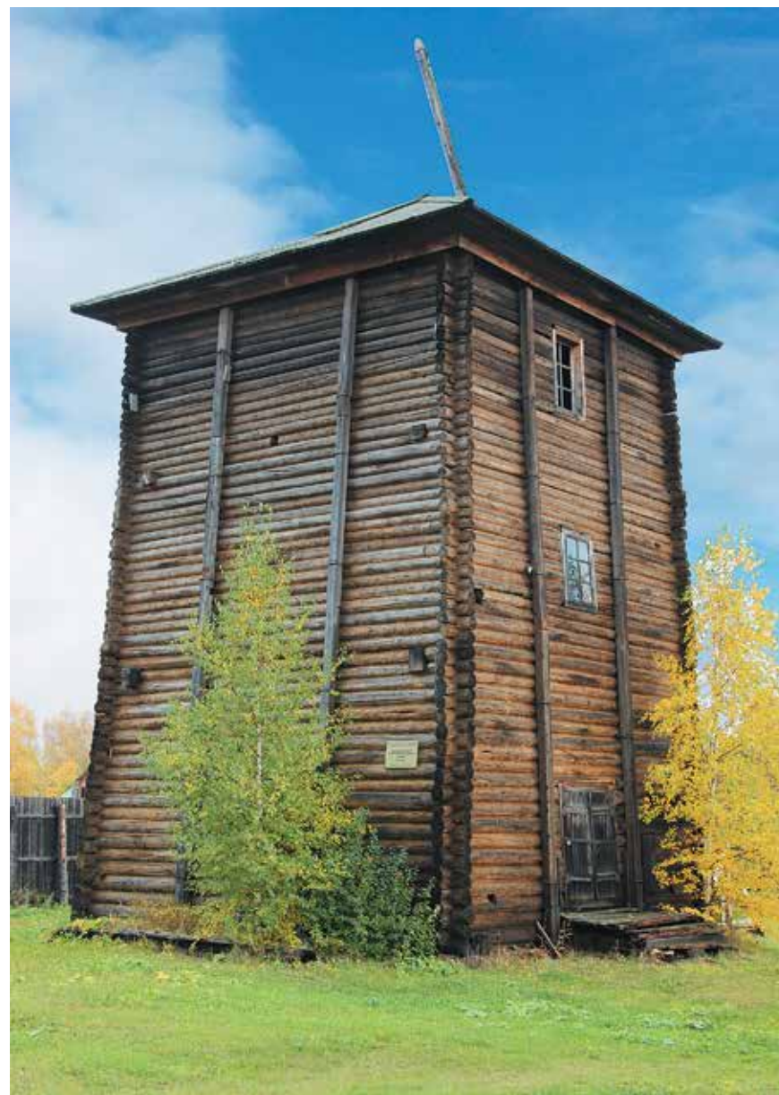
Рассолоподъемная клетка (башня, буровая) Усть-Боровского завода.
