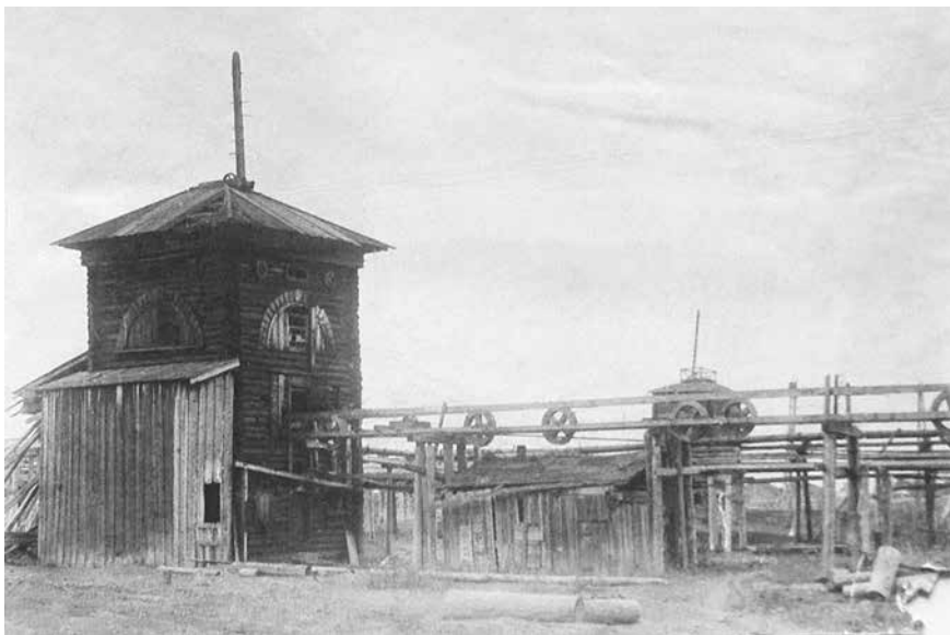
Горизонтальные штанги или «тяги» от паровой машины к насосу.
