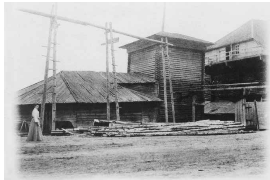
Желоб для подачи рассола, установленный на опорах.
